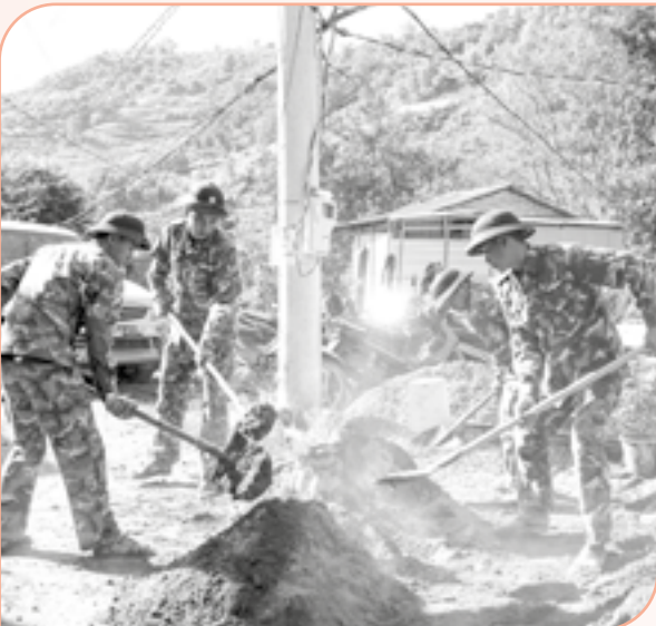
● Cán bộ, chiến sĩ Lữ đoàn 162 và Lữ đoàn 101 (Vùng 4 Hải quân) trộn hồ chuẩn bị xây dựng.
