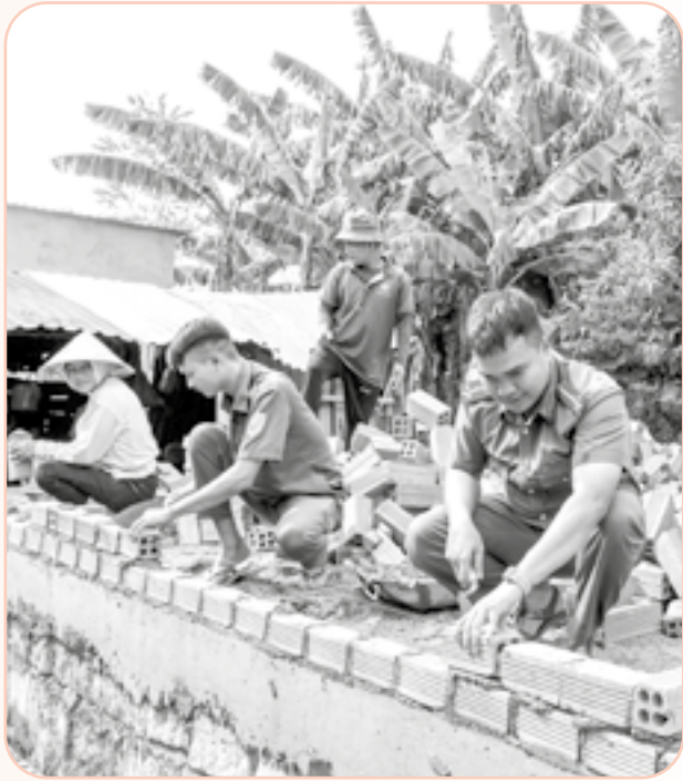
● Cán bộ Công an xã Diên Điền hỗ trợ người dân dựng nhà mới.
