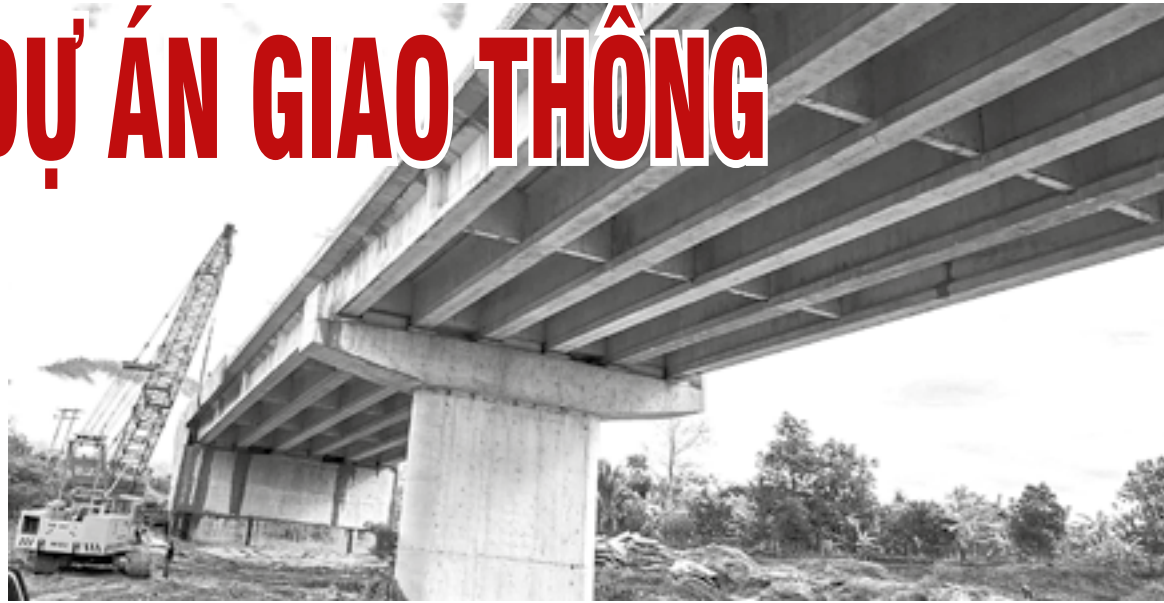
● Thi công tại công trình cầu Sông Giang.
