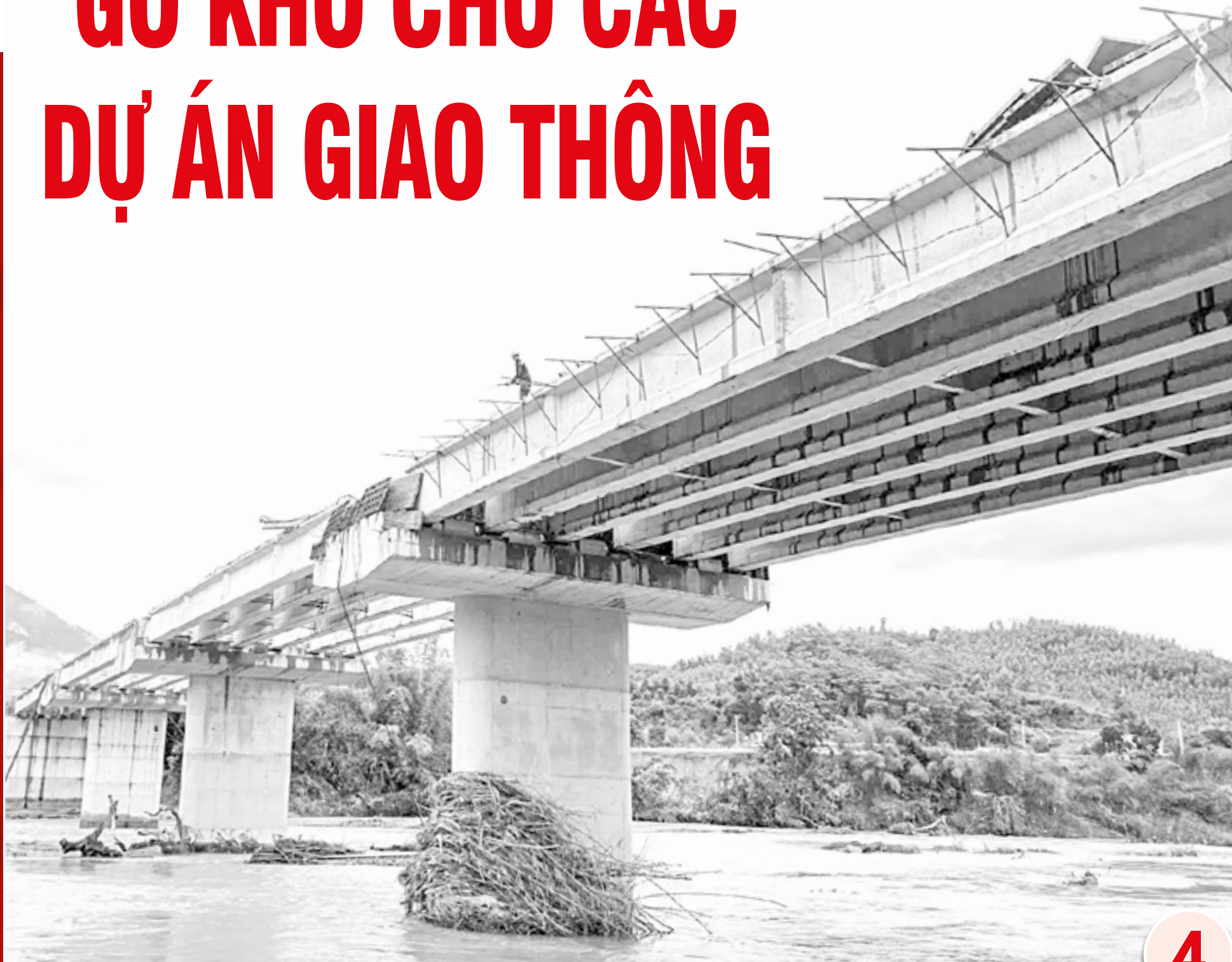
● Cầu Thác Ngựa trên địa bàn xã Khánh Vĩnh đã hoàn thành lao dầm, đang hoàn thiện mặt cầu.
