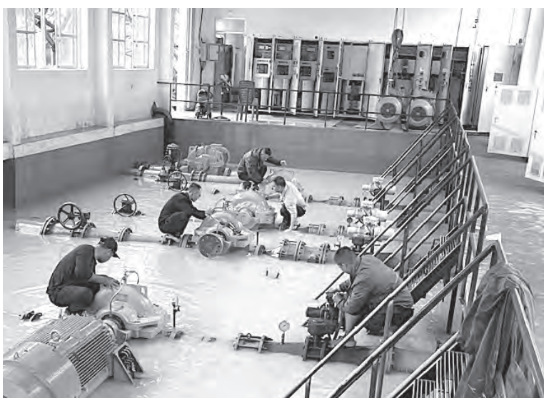
● Xử lý hệ thống trạm bơm bị ngập của Công ty Cổ phần Cấp thoát nước Khánh Hòa.
