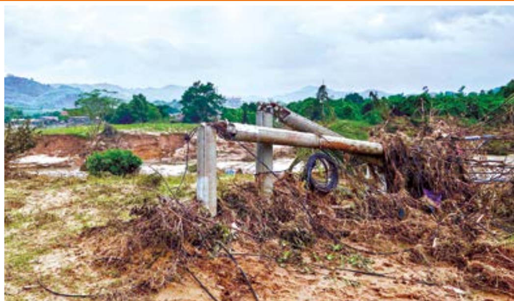
● Nhiều cột điện tại khu vực xã Tây Khánh Vĩnh bị gãy, đổ.
