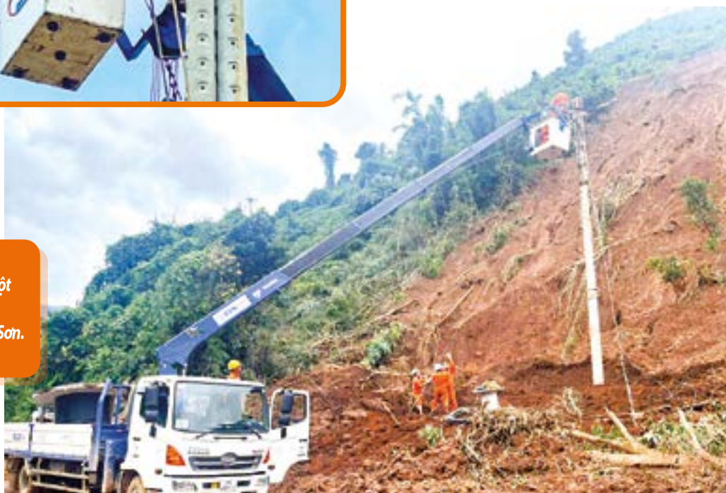
● Công nhân Công ty Cổ phần Điện lực Khánh Hòa kéo dây, khôi phục lưới điện.
