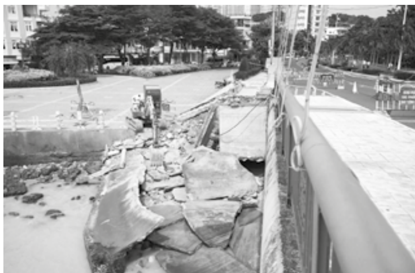
● Đơn vị bảo trì xử lý vị trí sạt lở ở kè chân cầu Trần Phú.
