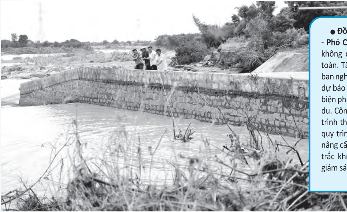
● Nhân viên Trạm Quản lý Hệ thống thủy lợi Nha Trinh thu gom rác nổi tại cống lấy nước đầu kênh Nam (xã Phước Hậu), nhằm thông thoáng cửa xả, cửa tràn tự do.
