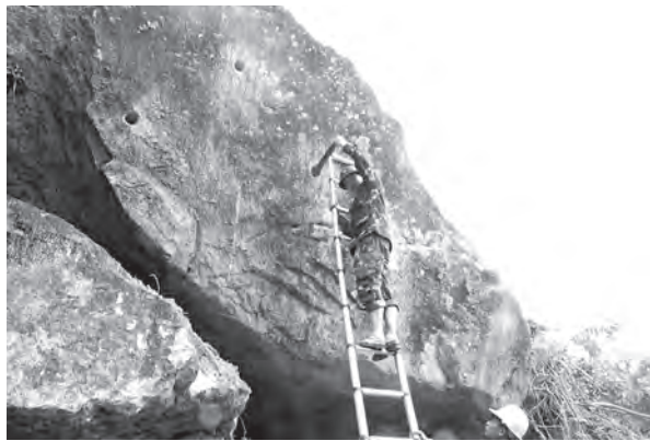
● Lực lượng công binh tiến hành khoan định vị để nới rộng đường.
