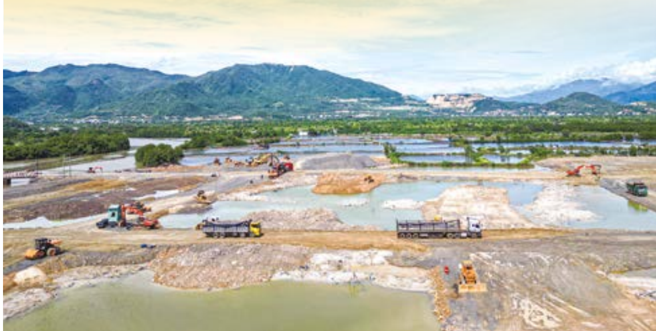
● Thiết bị máy móc được huy động để thi công.
