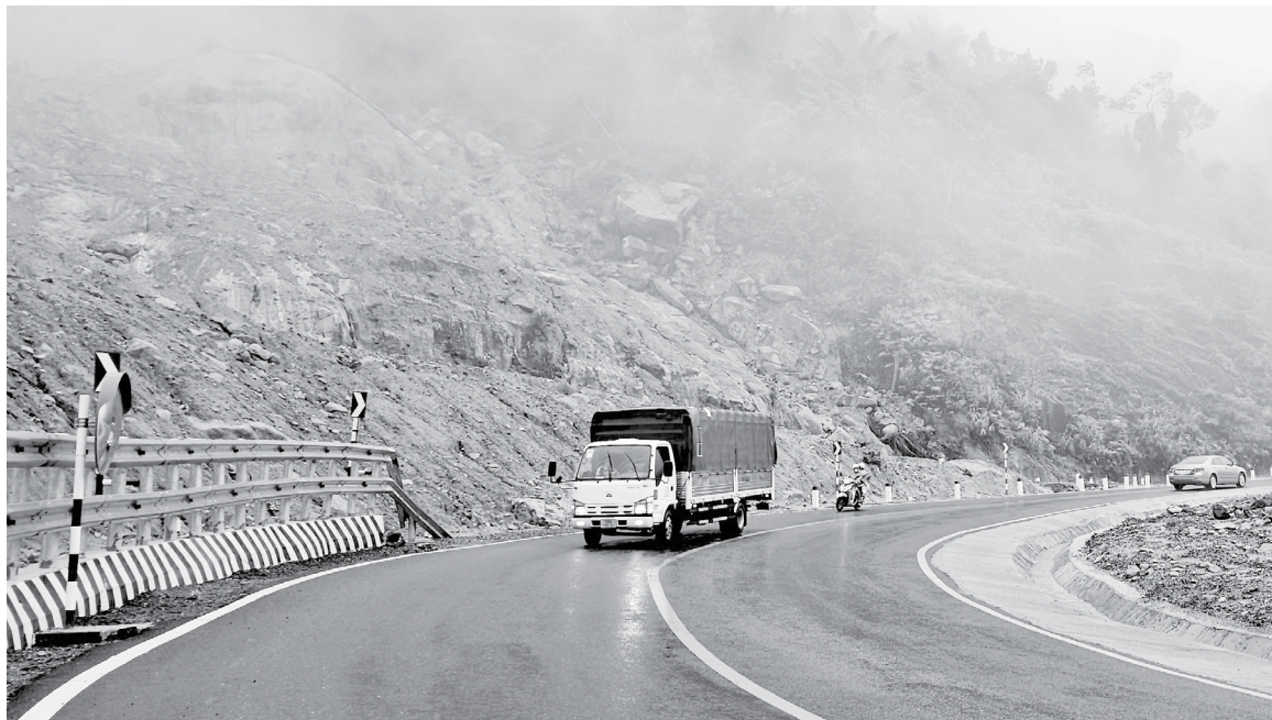
● Đèo Khánh Lê đã được kịp thời sửa chữa, khắc phục các vị trí sạt lở, đảm bảo lưu thông an toàn trong mùa mưa lũ.
