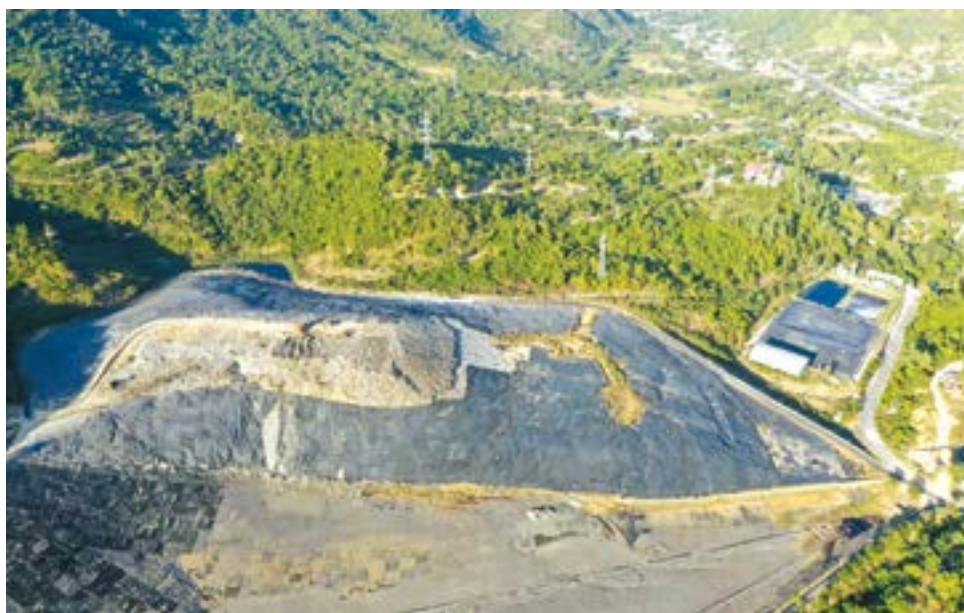
● Bãi chôn lấp và Trạm xử lý nước rỉ rác Lương Hòa - nơi thu gom, xử lý rác thải cho toàn bộ khu vực Nha Trang.
