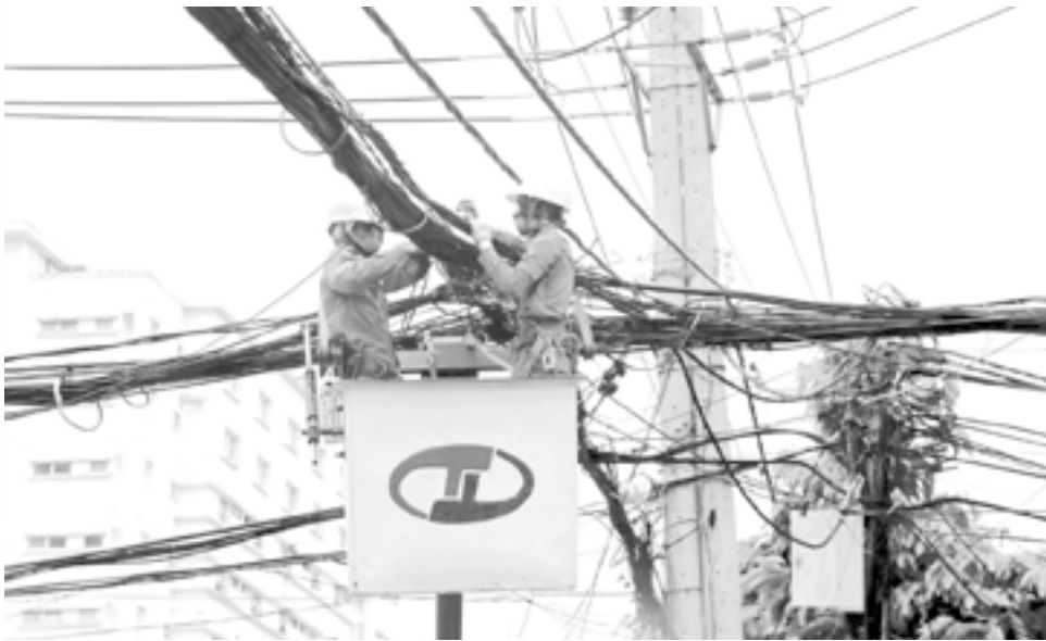
● Xí nghiệp Dịch vụ Điện lực Khánh Hòa tiến hành bó gọn các sợi cáp viễn thông.
