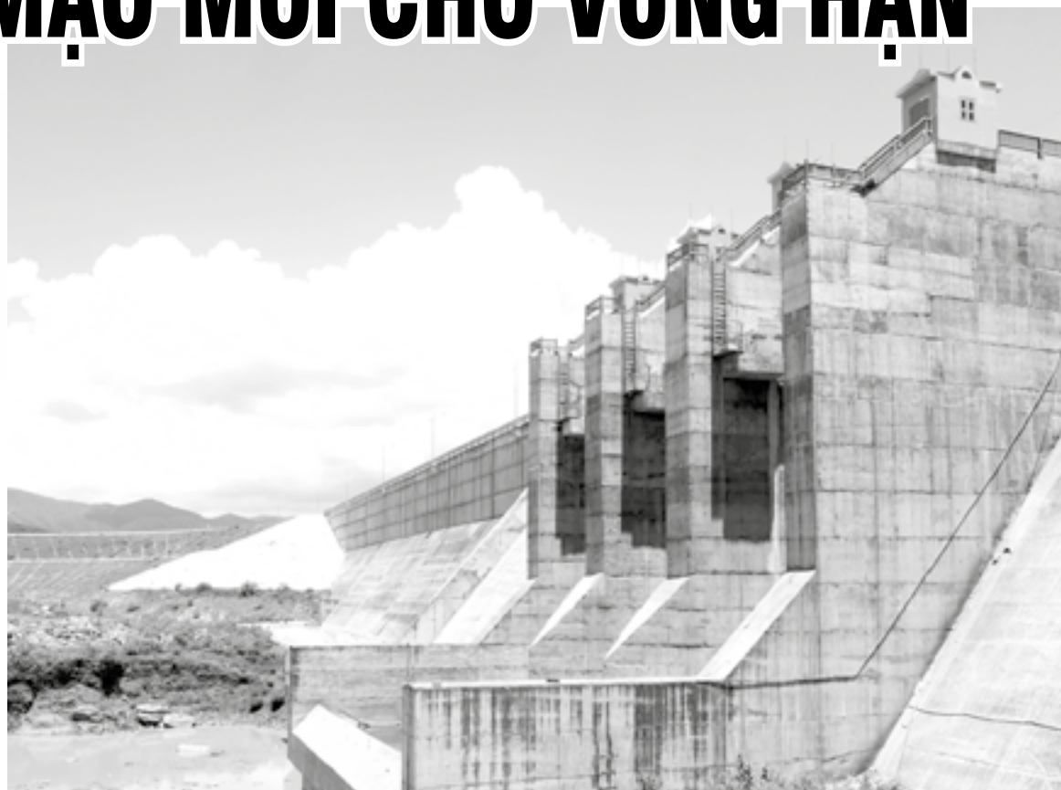
● Đập bê tông trọng lực nhánh trái - hạng mục chính của dự án dài 304m, cao 39m.
