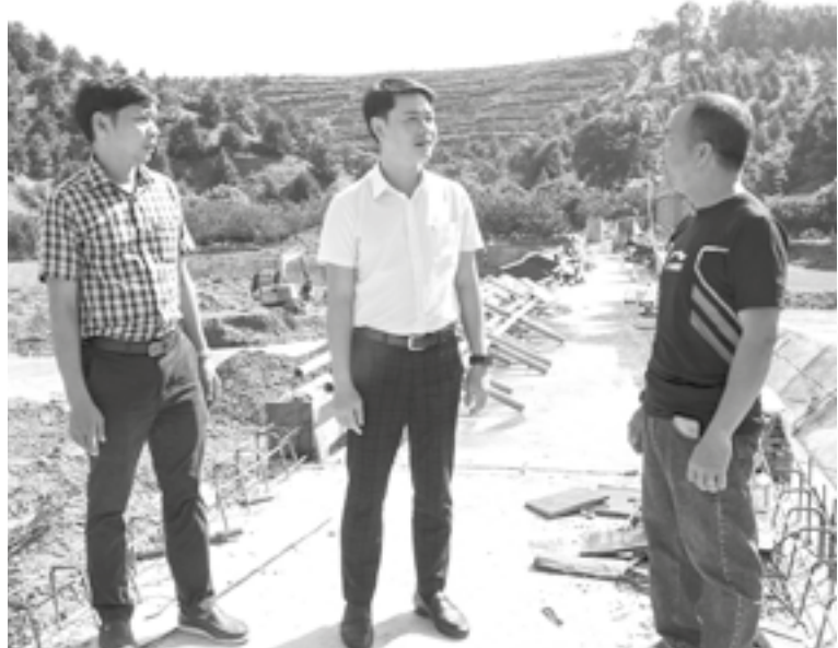
● Ông Bùi Hoài Nam (giữa) kiểm tra tiến độ dự án đập dâng Tô Hạp.
