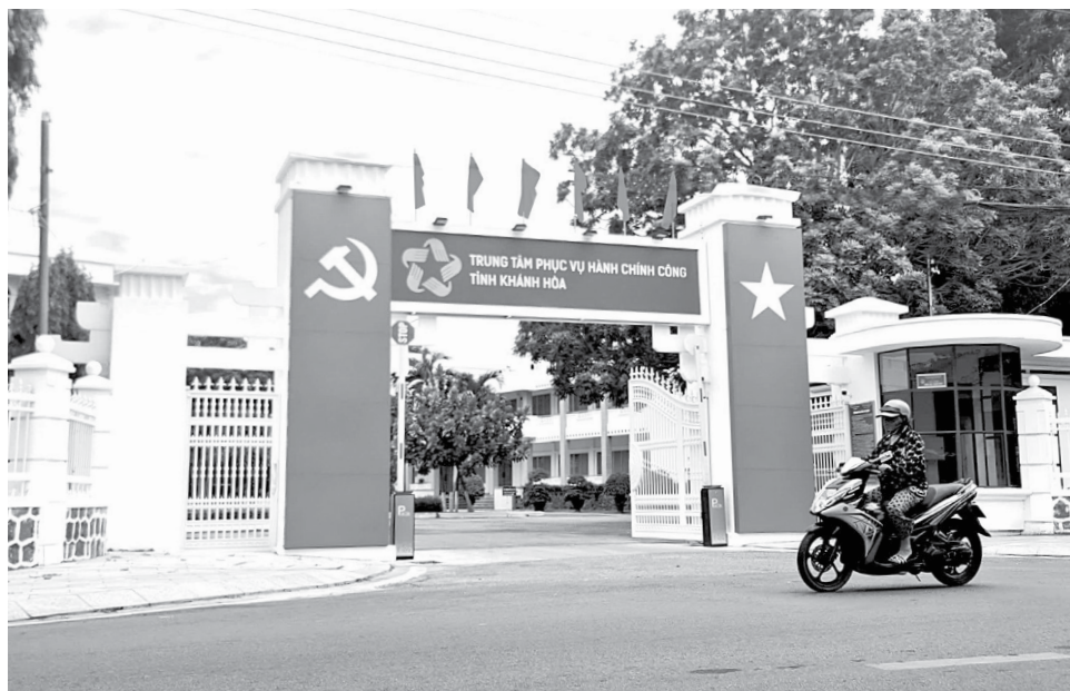
● Trụ sở UBND tỉnh Ninh Thuận cũ tại số 450 Thống Nhất, Phan Rang được chuyển đổi công năng thành Trung tâm Phục vụ hành chính công tỉnh Khánh Hòa (cơ sở 2).
