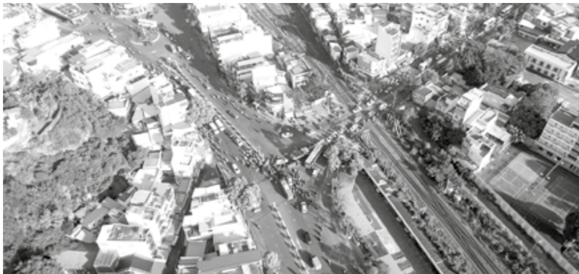
● Nút giao Mả Vòng tương đối phức tạp do gần đường sắt, cần cải tạo lại từ nút giao đồng mức thành nút giao khác mức.
