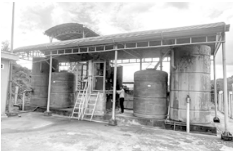
● Công trình nâng cấp hệ thống nước sinh hoạt Sơn Bình đã hoàn thành việc đầu tư, cấp nước sạch cho người dân.
