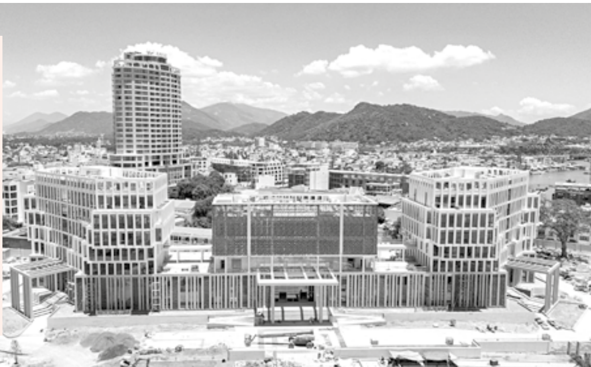
● Công trình trụ sở làm việc của Tỉnh ủy, Đoàn Đại biểu Quốc hội và HĐND tỉnh, UBND tỉnh đang trong quá trình hoàn thiện.
