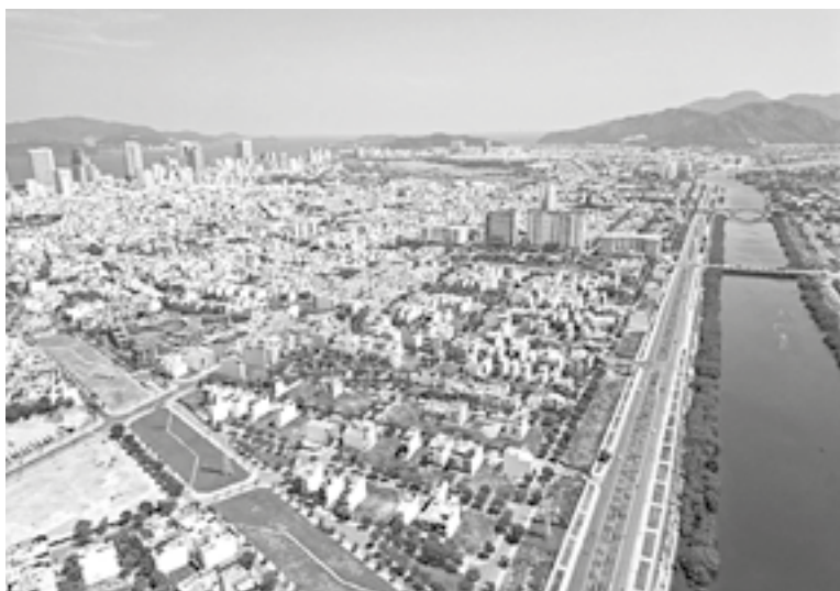
● Tại TP. Nha Trang nhiều dự án nhà ở thương mại đã được xây dựng và đi vào hoạt động. Ảnh: MẠNH HÙNG
