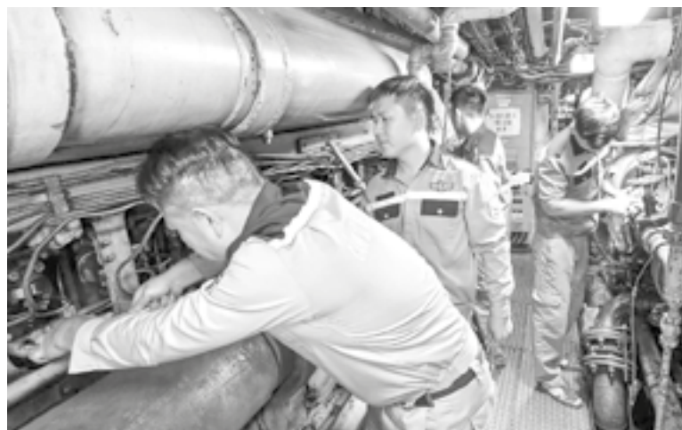
● Cán bộ, chiến sĩ Hải đoàn Cảnh sát biển 32 bảo trì, bảo dưỡng thiết bị trong khoang máy tàu.
