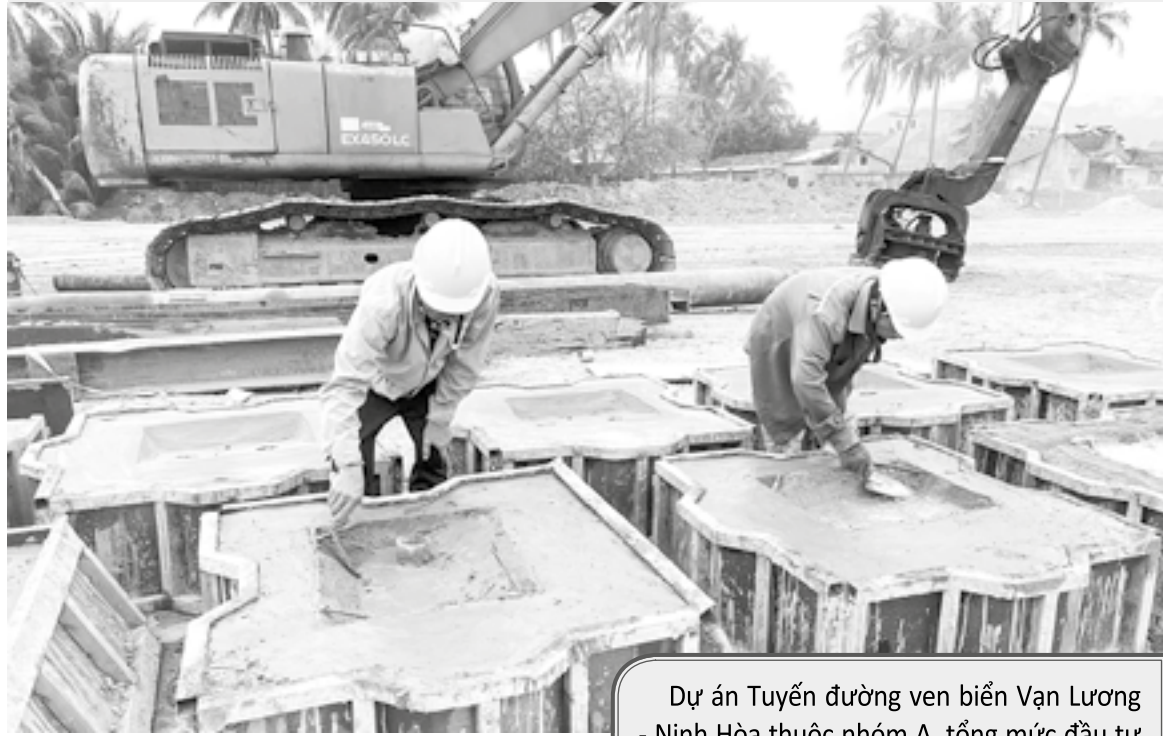
● Nhà thầu đúc bê tông để sẵn sàng thi công dự án.
