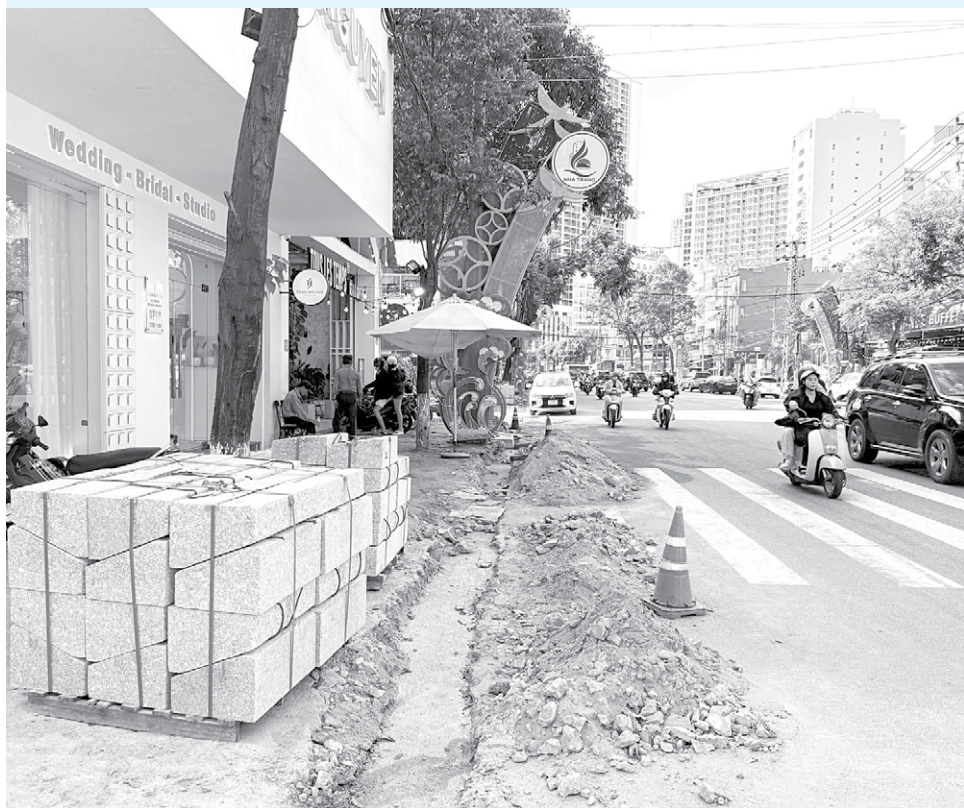
● Vỉa hè đường Lê Thánh Tôn đang được hoàn thiện.
