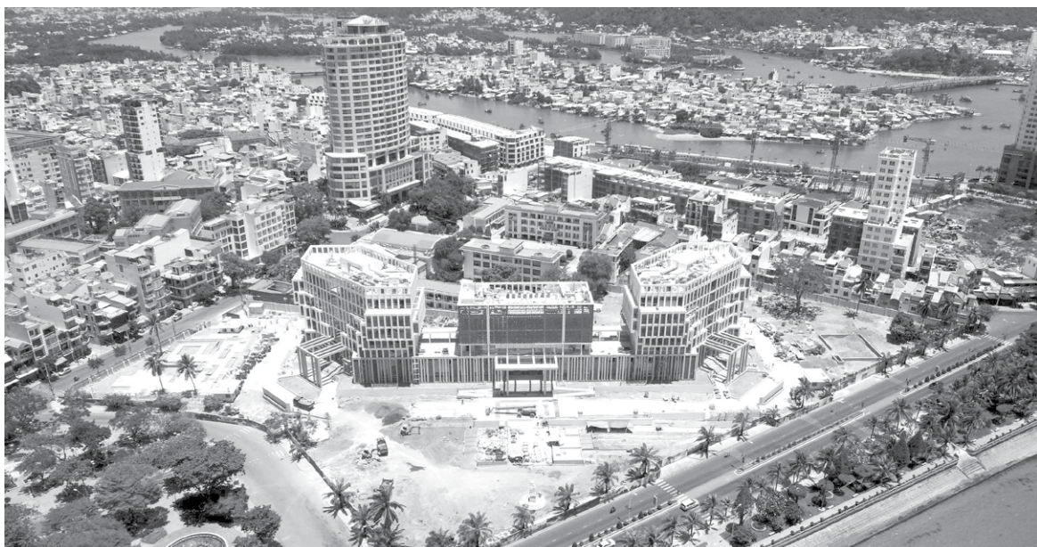
● Trụ sở Tỉnh ủy, Đoàn Đại biểu Quốc hội và HĐND, UBND tỉnh đang được gấp rút hoàn thiện.
