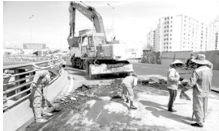
● Đơn vị thi công bóc lớp bê tông nhựa tại vị trí lún trên nút giao Ngọc Hội.
