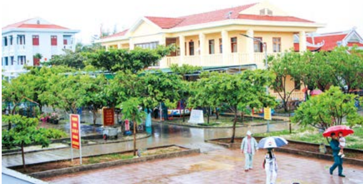
● Những công trình được đầu tư xây dựng khang trang, cùng hệ thống cây xanh trên đảo Đá Tây.
