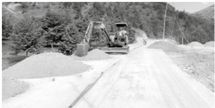
● Dự án xây dựng tuyến đường thôn Tha Mang (xã Ba Cùm Bắc) đi thôn Tà Lương (thị trấn Tô Hạp) bị ảnh hưởng tiến độ do công tác giải phóng mặt bằng.
