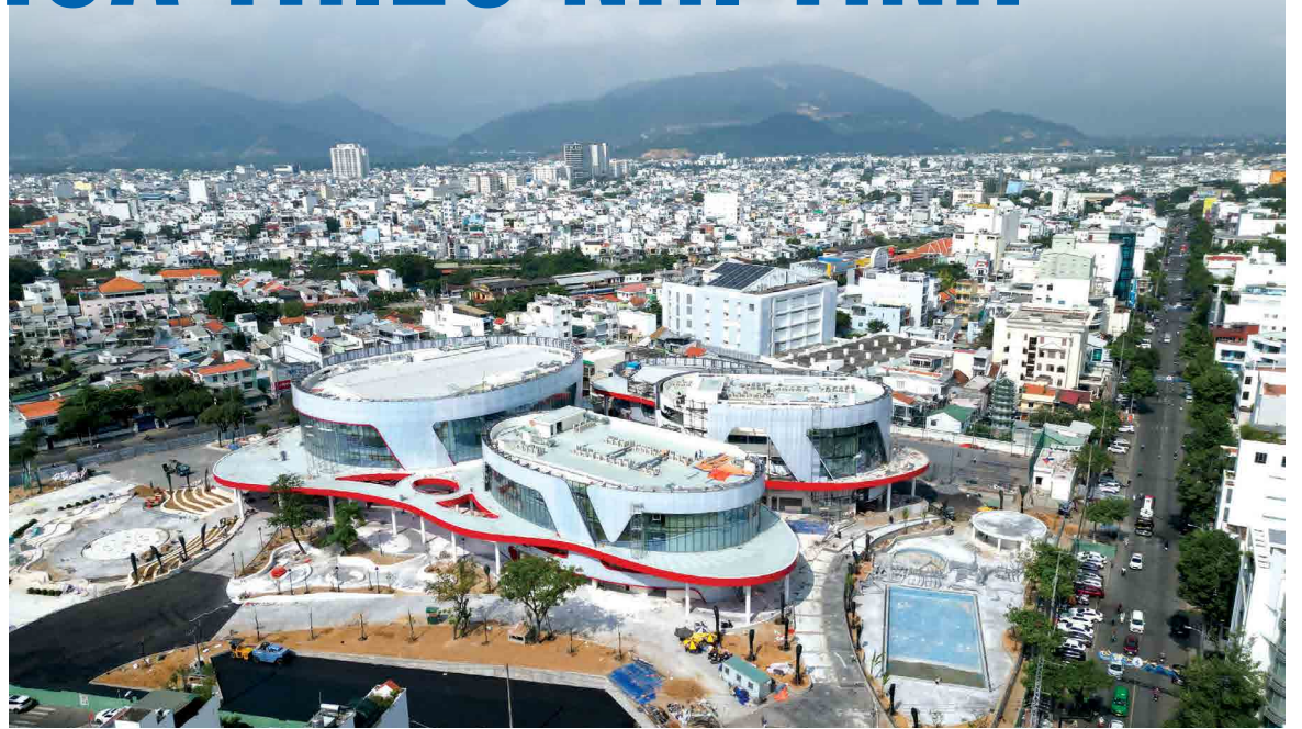
● Công trình đang bước vào giai đoạn nước rút hoàn thiện.
