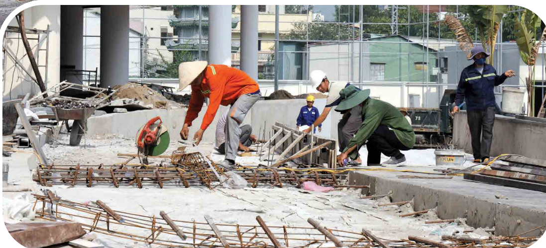
● Các công nhân đang khẩn trương thi công công trình.
