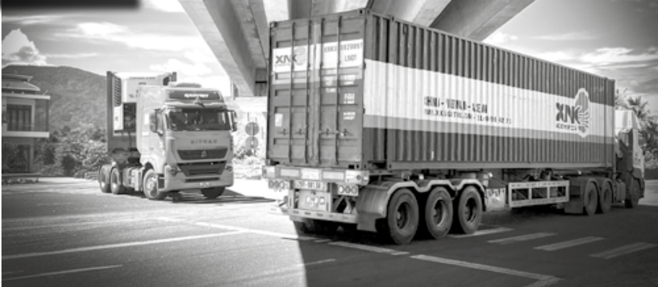
● Tại vị trí đường dẫn từ đường bộ cao tốc đoạn Nha Trang - Cam Lâm ra Quốc lộ 1 (dưới gầm cầu vượt Tỉnh lộ 3) tồn tại bất cập do bị khuất tầm nhìn, ban đêm không đủ ánh sáng.
