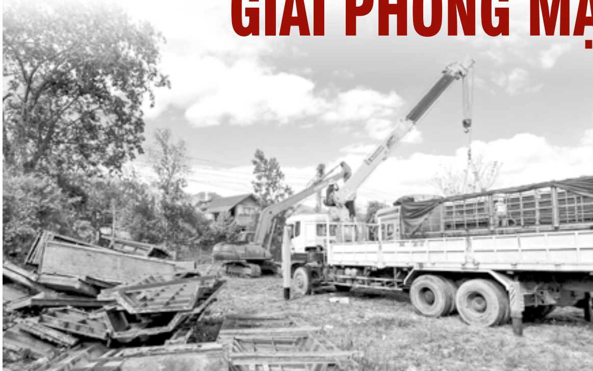
● Máy móc, vật tư đã được nhà thầu thi công tập kết tại khu vực thuộc xã Sơn Lâm, huyện Khánh Sơn.
