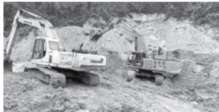
● Công ty Cổ phần Quản lý và xây dựng đường bộ Khánh Hòa đang cho máy múc nỗ lực dọn bùn đất ở km43.
