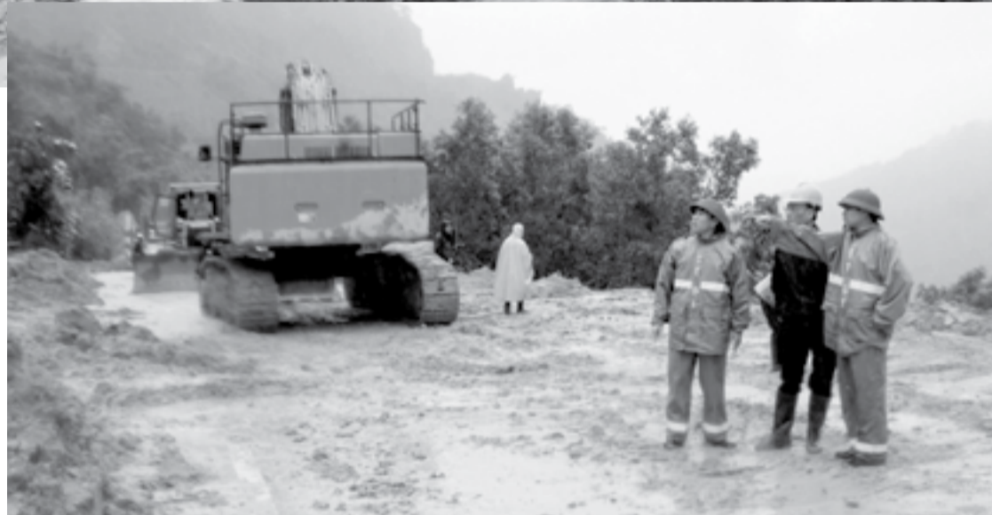
● Lãnh đạo Công ty Cổ phần Quản lý và xây dựng đường bộ Khánh Hòa và Văn phòng Quản lý đường bộ III.3 liên tục bám hiện trường chỉ đạo công tác khắc phục.
