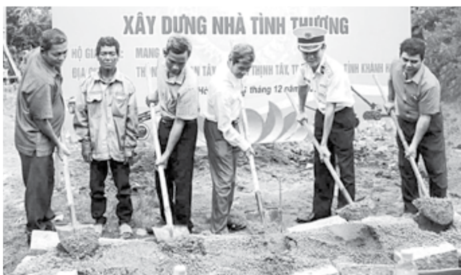
● Đại diện Lữ đoàn 957 và địa phương thực hiện nghi thức khởi công xây dựng nhà cho gia đình ông Mang Sai.
