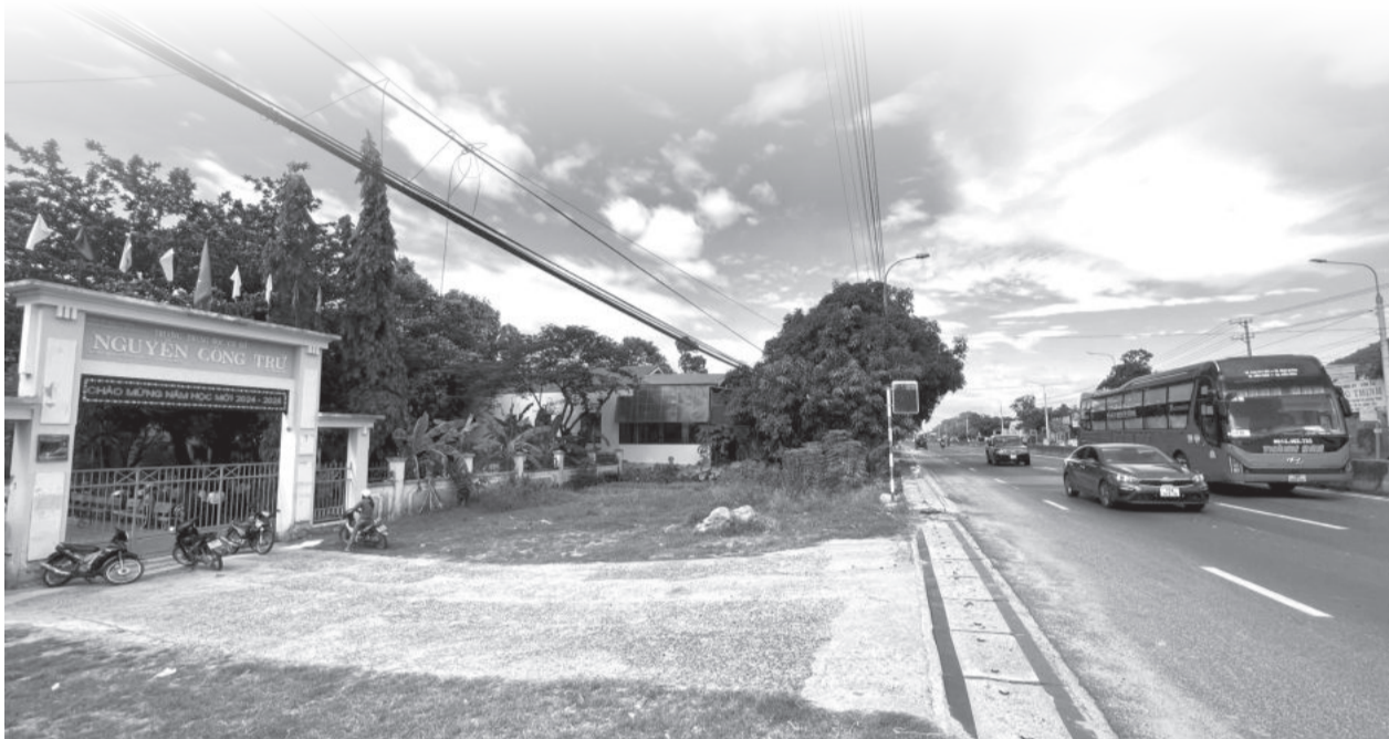
● Đoạn Quốc lộ 1 qua khu vực Trường THCS Nguyễn Công Trứ (xã Vinh Phương, TP. Nha Trang).
