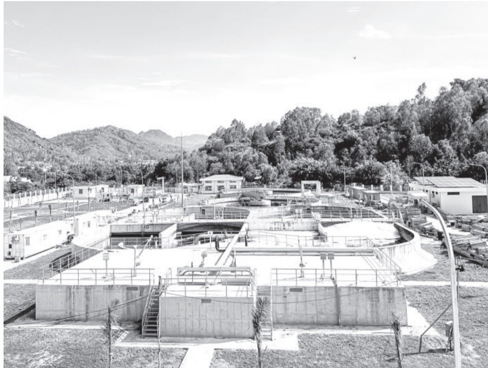
● Toàn cảnh Nhà máy xử lý nước thải phía bắc TP. Nha Trang.
