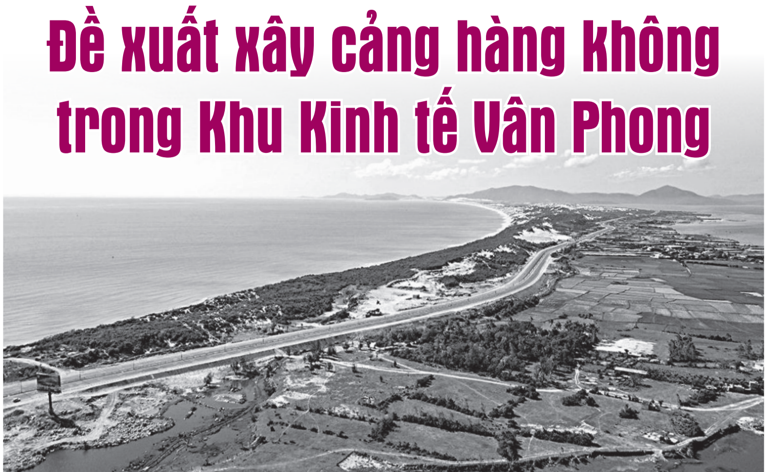
● Một góc khu vực Bắc Vân Phong - nơi được đề xuất xây dựng Cảng hàng không Vân Phong.
