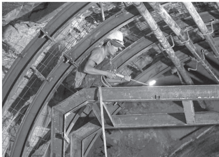
● Công nhân hàn khung sắt gia cố mái hầm.
