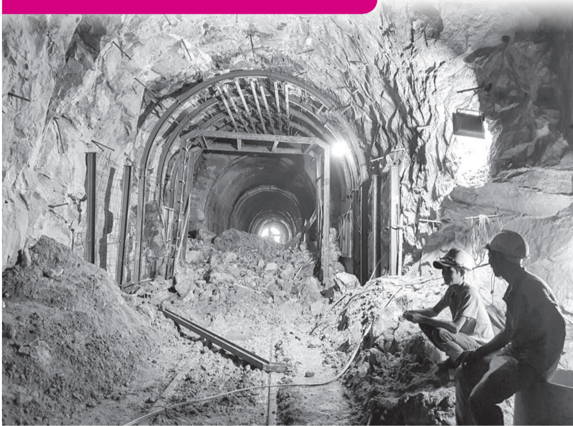
● Hầm đường sắt Bãi Gió bị sạt lở, không thể lưu thông từ trưa 12-4 đến nay.
