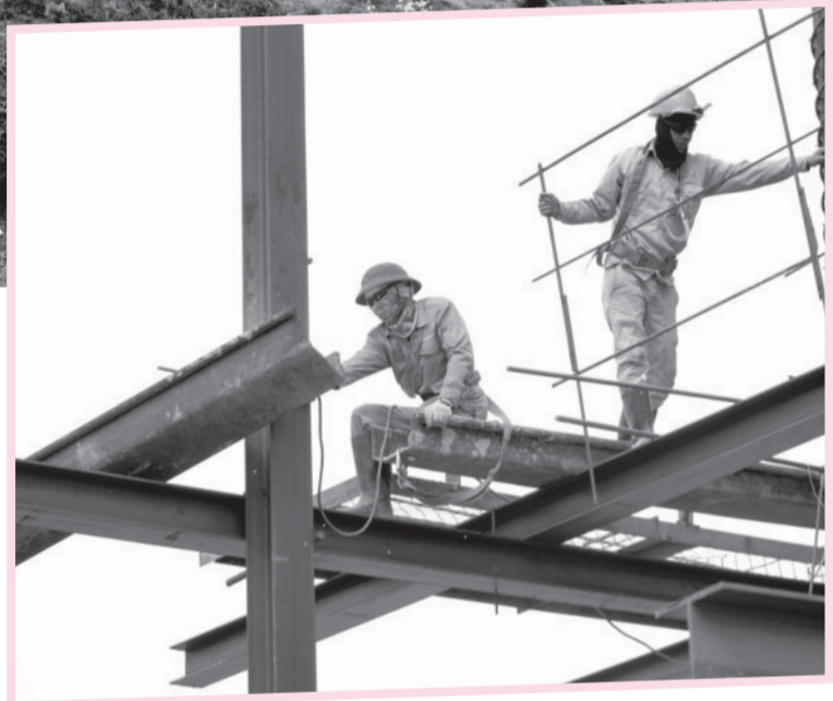
● Công nhân thi công trên công trường đường bộ cao tốc Khánh Hòa - Buôn Ma Thuột.
