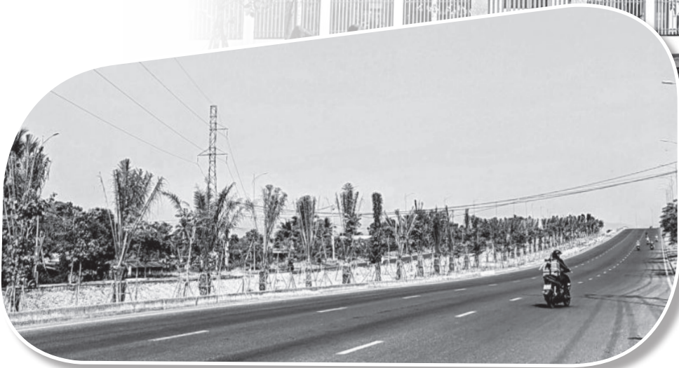
● Đường Võ Nguyên Giáp nhìn về hướng cầu Lùng.
