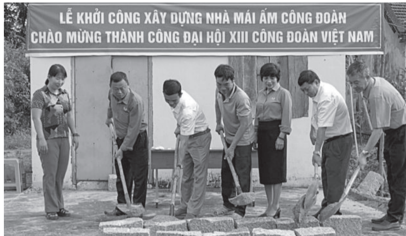
● Khởi công xây dựng một nhà “Mái ấm công đoàn”.
