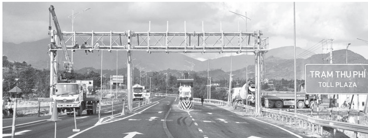
● Trạm thu phí trên tuyến đường bộ cao tốc Nha Trang - Cam Lâm đang được lắp đặt thiết bị.
