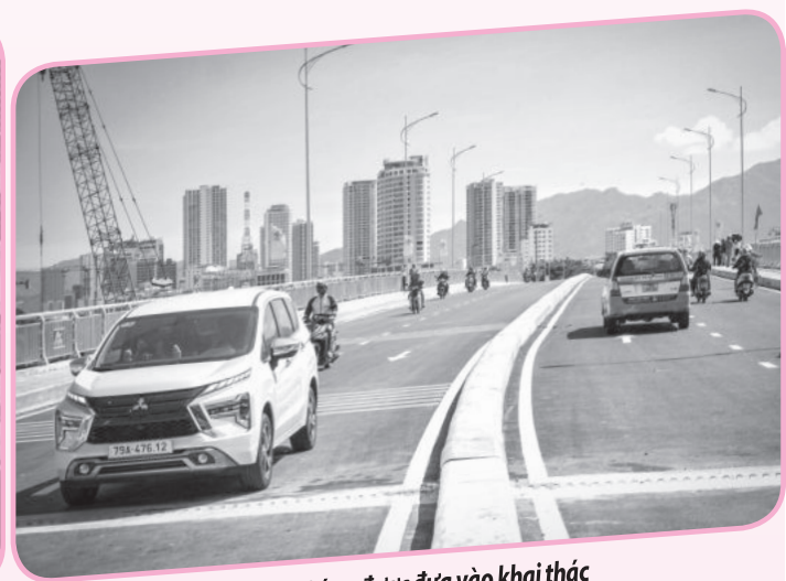
● Cầu Xóm Bông được đưa vào khai thác giảm tải áp lực giao thông cho cầu Trần Phú.
