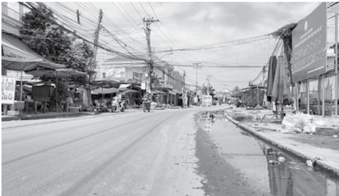
● Tình trạng ngập nước trên Tỉnh lộ Nguyễn Huệ đoạn qua địa bàn xã Vạn Thắng, huyện Vạn Ninh diễn ra trong nhiều năm nay.
