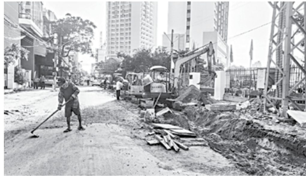
● Thi công đường Phan Chu Trinh (TP. Nha Trang).
