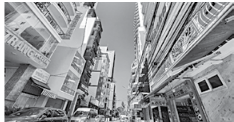
● Có ít nhất 6 khách sạn trong hẻm 96B Trần Phú bị đình chỉ hoạt động do không đảm bảo an toàn phòng cháy, chữa cháy.
