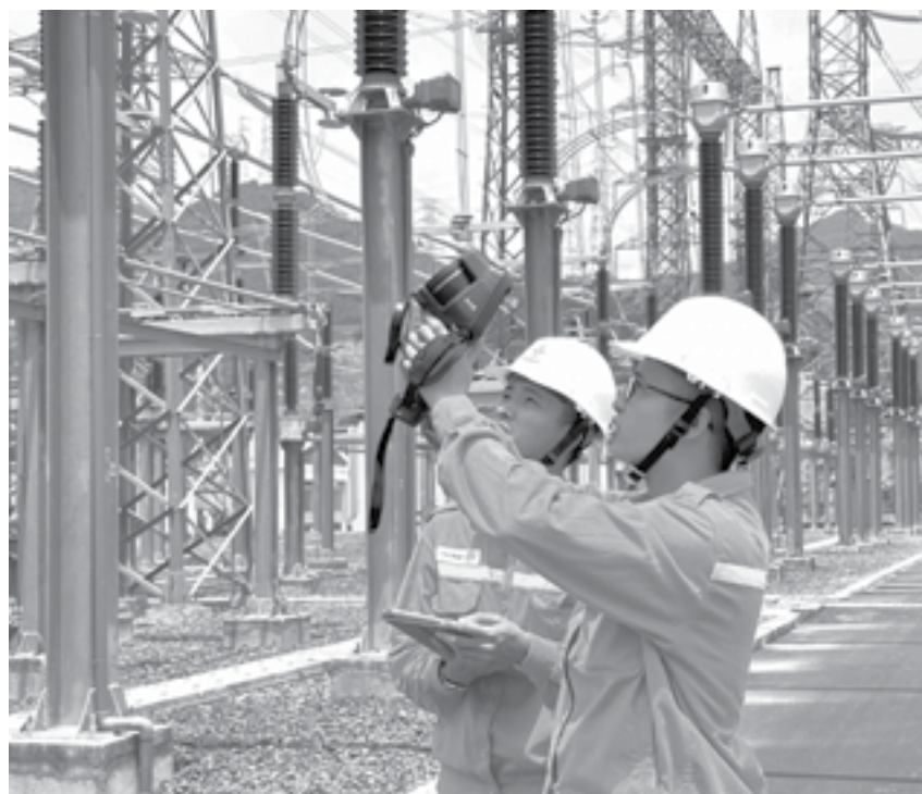
● Kiểm tra đo phát nhiệt thiết bị tại Trạm biến áp 500kV Vân Phong.
