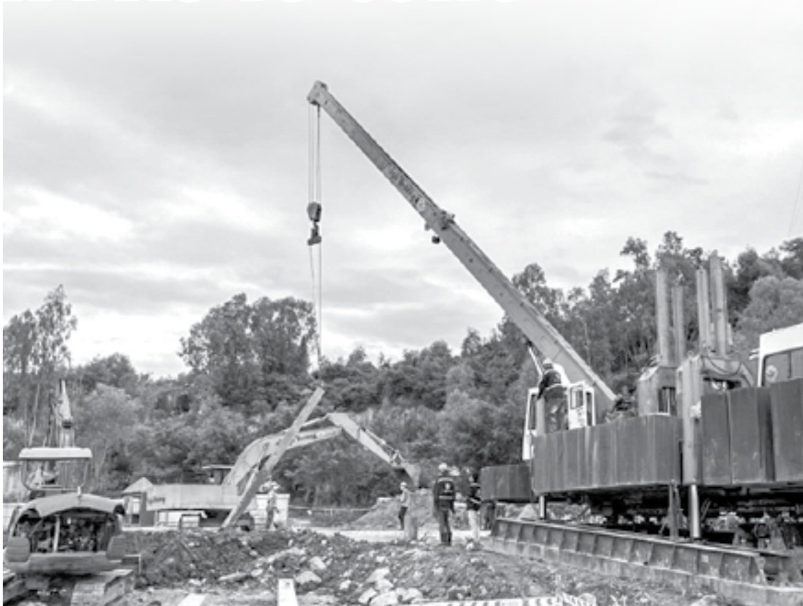
● Thi công hạng mục thuộc Dự án Môi trường bền vững các thành phố duyên hải - Tiểu dự án Nha Trang.
